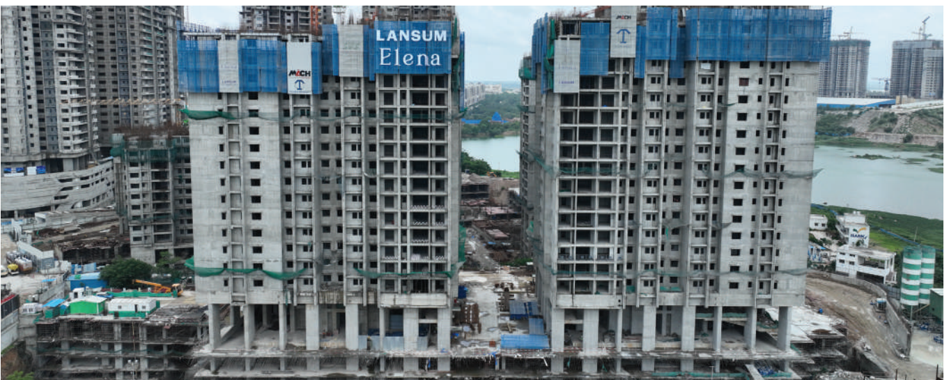
Tower A & B Progress (August, 2026)
